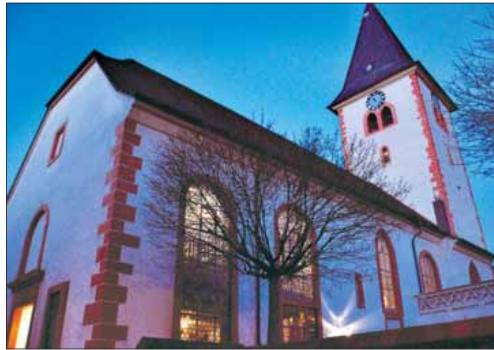
Die evangelische Mauritiuskirche im alten Leimener Stadtkern. Foto: PS Geschwill
